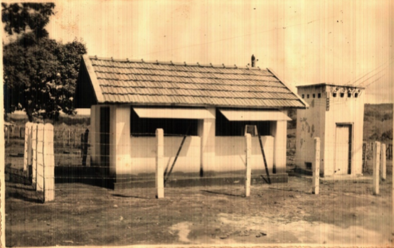
GERADOR DE ENERGIA ELÉTRICA E RESPECTIVO TRANSFORMADOR
